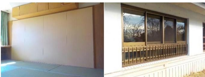
各居室の壁や建具を修繕し、一部窓枠の老朽化によりサッシに入れ替えました。
