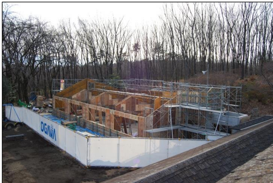
居室拡張工事の様子
